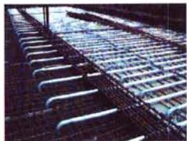
Einbringung konditionierter Frischluft über betonkernintegrierte Luftleitungen. Dadurch Frischluftversorgung und Thermische Bauteilaktivierung für die Grundlast Heizen und Nachtauskühlung im Sommer
