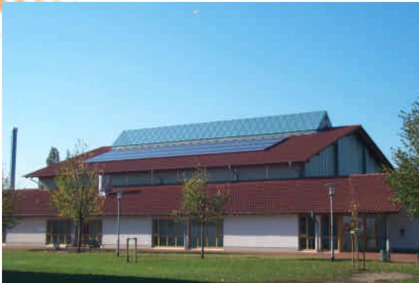
10 kWp Photovoltaikanlage auf dem Dach der Sporthalle Ginsheim
