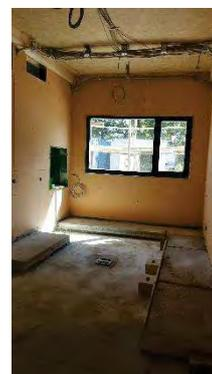
Vorbereitungsküche mit betonierten Sockeln, die zum Fliesen bereit sind
