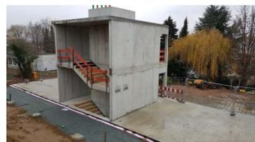
Fertiggestelltes Rohbau-Erdgeschoss mit Treppenhaus und Aufzugsschacht im November 2018
