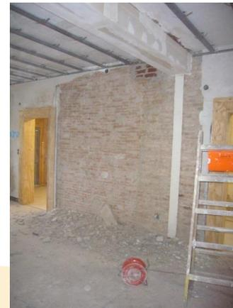
**Ausbau und Durchbrüche:** Montage Unterkonstruktion Decke, Deckenverkleidung und Deckenstabilisierung, Ausbesserung der Putzflächen
